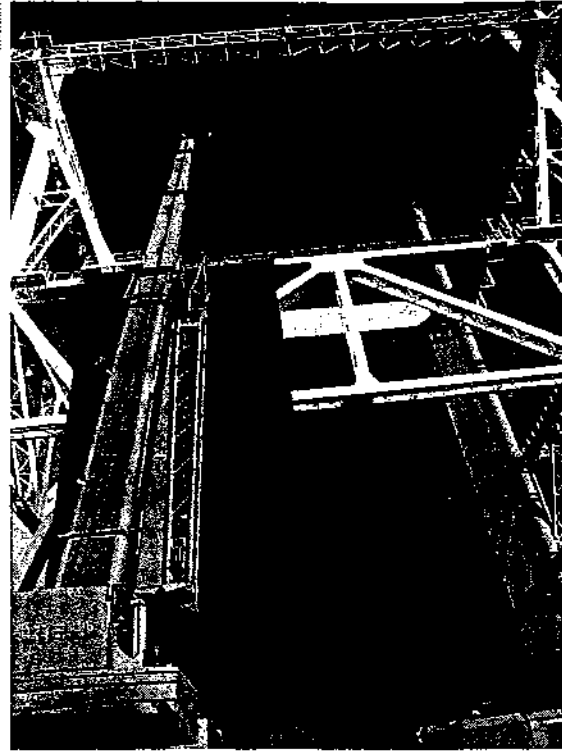
Desmontaje y retirada del puente-grúa de la nave piscinas.
