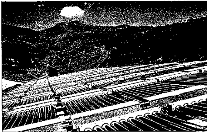
Camp de captadors solars de buit de 130 m 2 situat a la coberta dels cellers.
