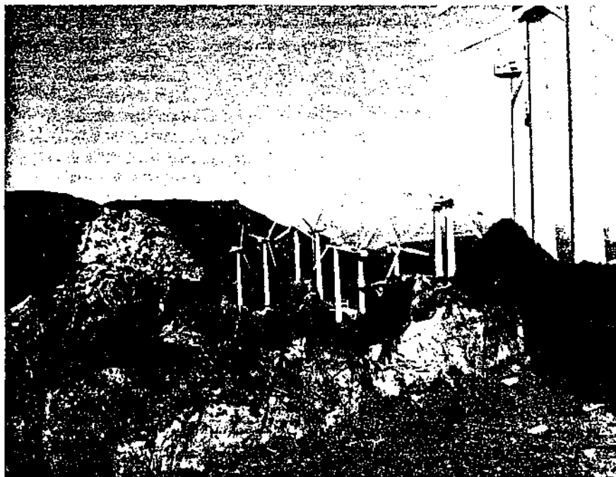
Parque eólico de Tarifa (Cádiz) perteneciente a la Sociedad Eólica de Andalucía.
